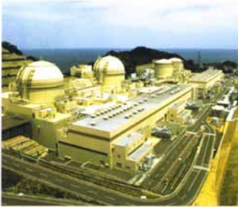
▲原子力発電所
